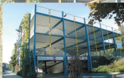
Parkhaus Zentrum Ost Neu-Ulmer-Straße
